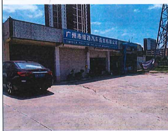
加油站西北侧
