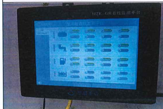
储罐和油管渗漏监测
