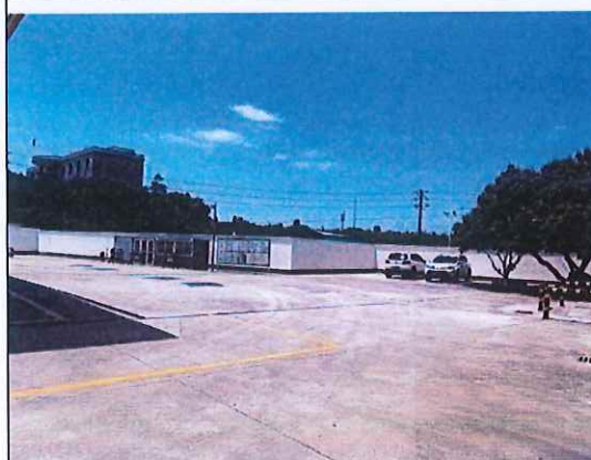
加油站西北侧
