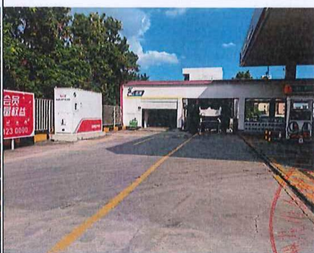
尾气处理液储存罐
