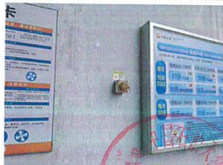
外墙紧急切断按钮
