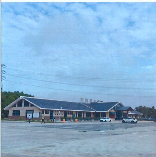
加油站西北侧
