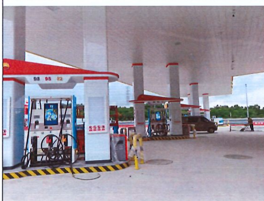
加油区—储罐区
