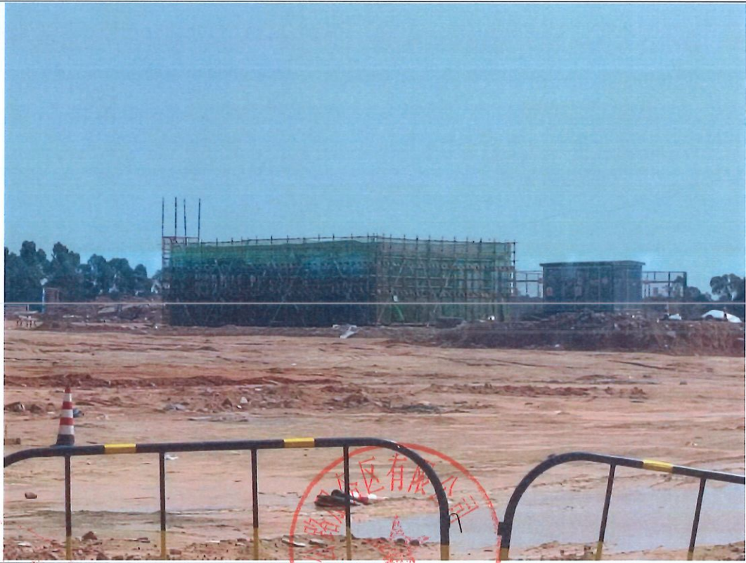
油站用地西南侧—箱式变压器及在建汽修房
