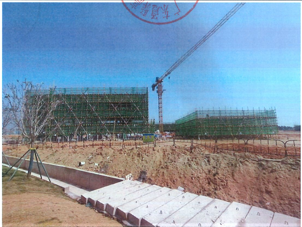
油站用地西侧—在建综合楼
