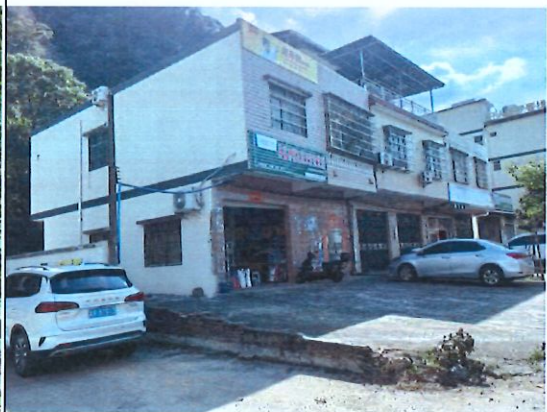
加油站西北侧
