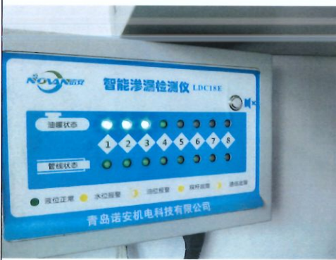
双层油罐在线渗漏监测系统
