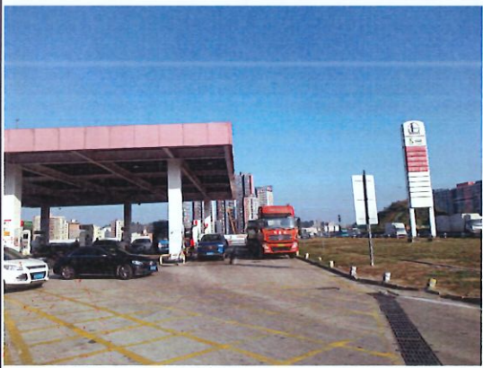
加油区、储罐区
