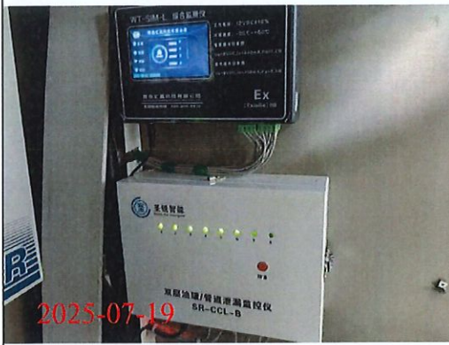
油罐—油管在线渗漏监测系统
