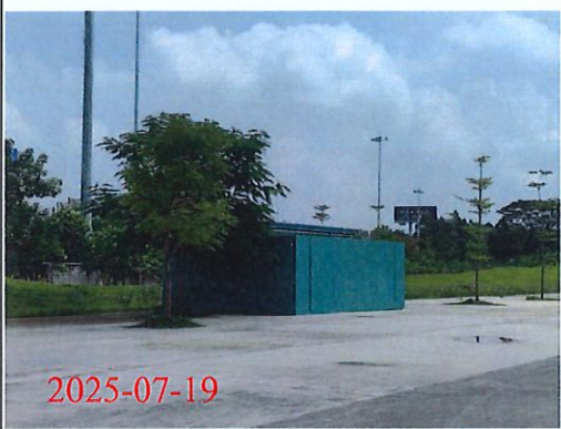
加油站西北侧
