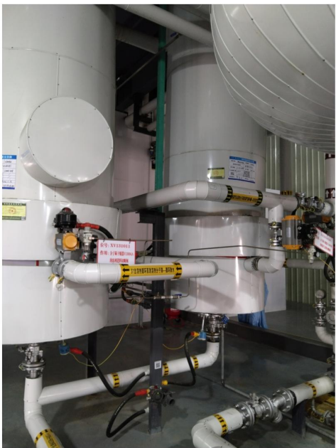
分子筛干燥器溶剂进料切断阀
