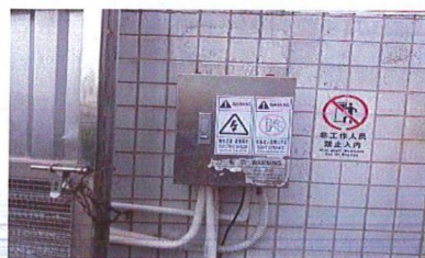
事故风机及紧急切断手动开关
