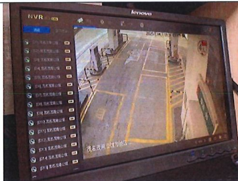
加油区视频监控画面
