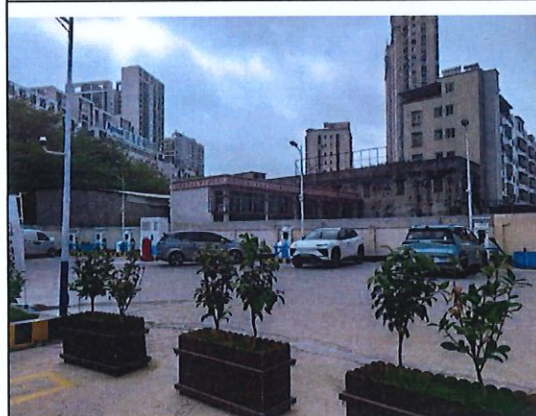
站区东部充电站
