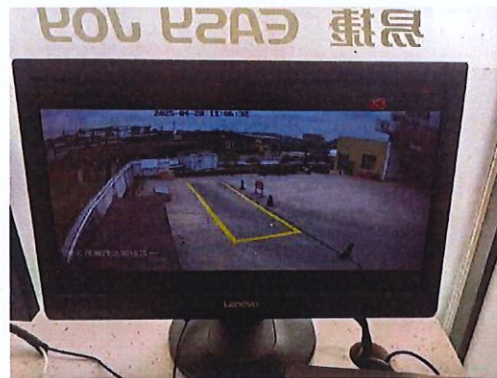
卸油区视频监控画面
