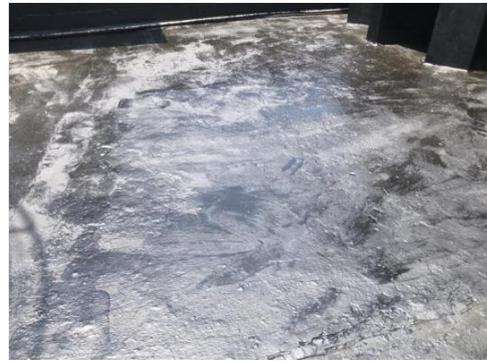
2、氨水储罐围堰有孔洞
