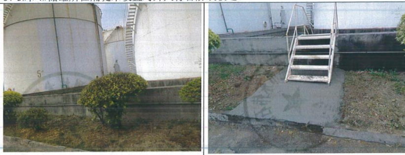
3、3#和4#储罐所在隔堤未设置对外人行台阶或坡道。
