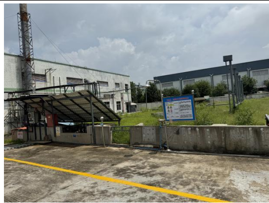
甲类埋地罐区
