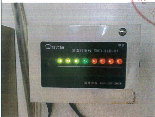
防渗罐池在线渗漏监测系统
