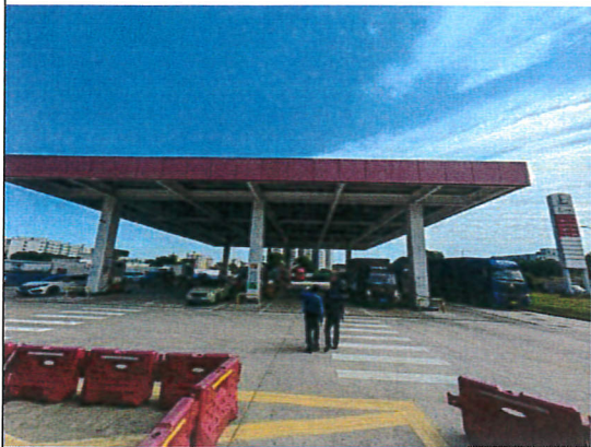
加油区、储罐区
