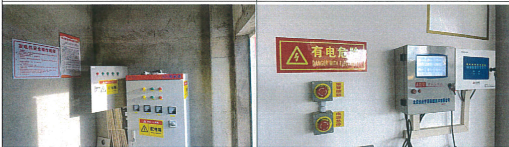
紧急切断按钮—液位计 双层罐双层管测漏报警仪
