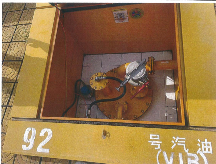
图 3: SF 双层油罐照片
