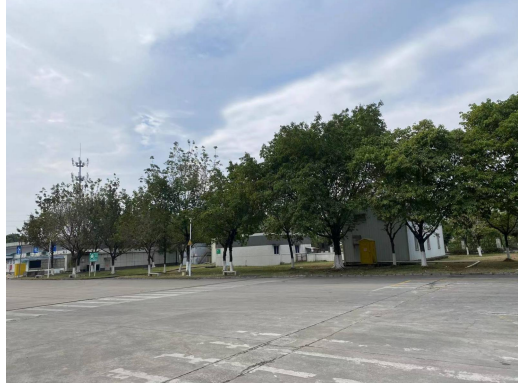
西面污水处理站
