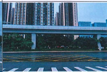
加油站西北侧
