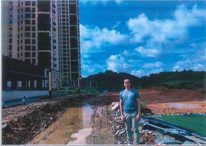
评价公司人员现场检查
