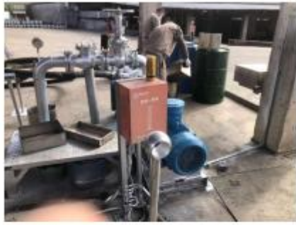
卸车静电接地
