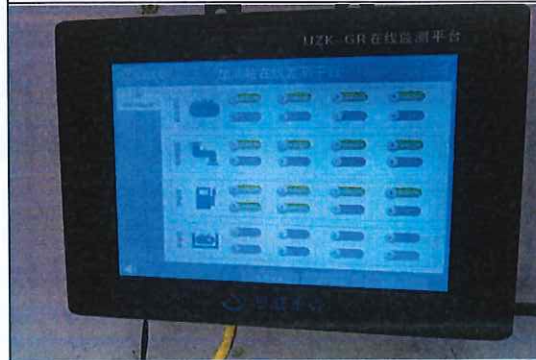
储罐和油管渗漏监测
