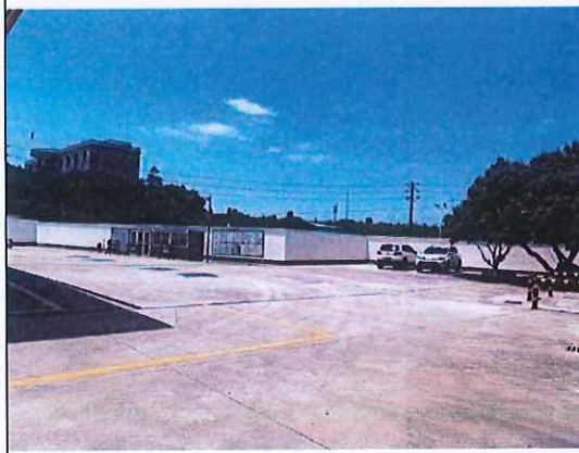
加油站西北侧
