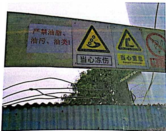
充装间、液氧储罐处设置“严禁油脂、油污、油类”标识
