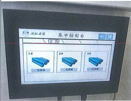
油管在线泄漏监测系统
