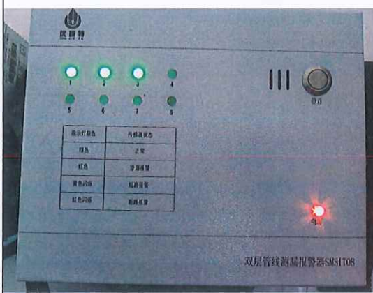
双层管道在线渗漏监测系统
