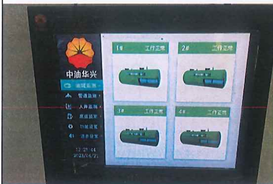
防渗罐池在线渗漏监测系统
