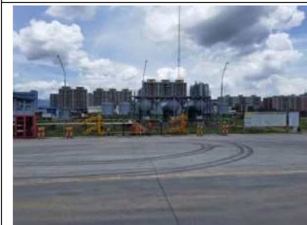
甲类溶剂罐区
