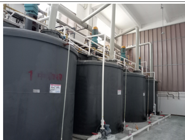
工业氧化铌车间乙类区
