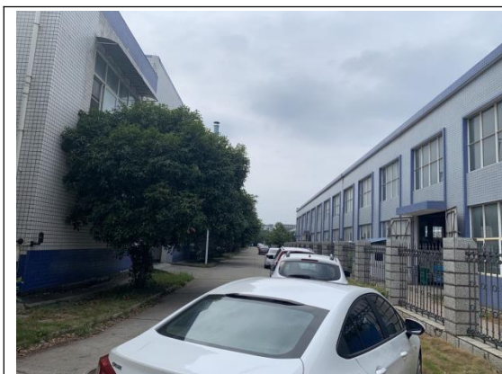
北侧 株洲瀚洋模具公司
