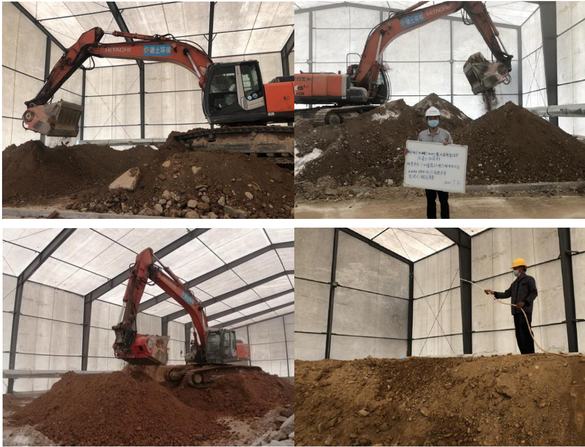
图2.3-15化学氧化施工（加药混合、加水养护）过程图片
