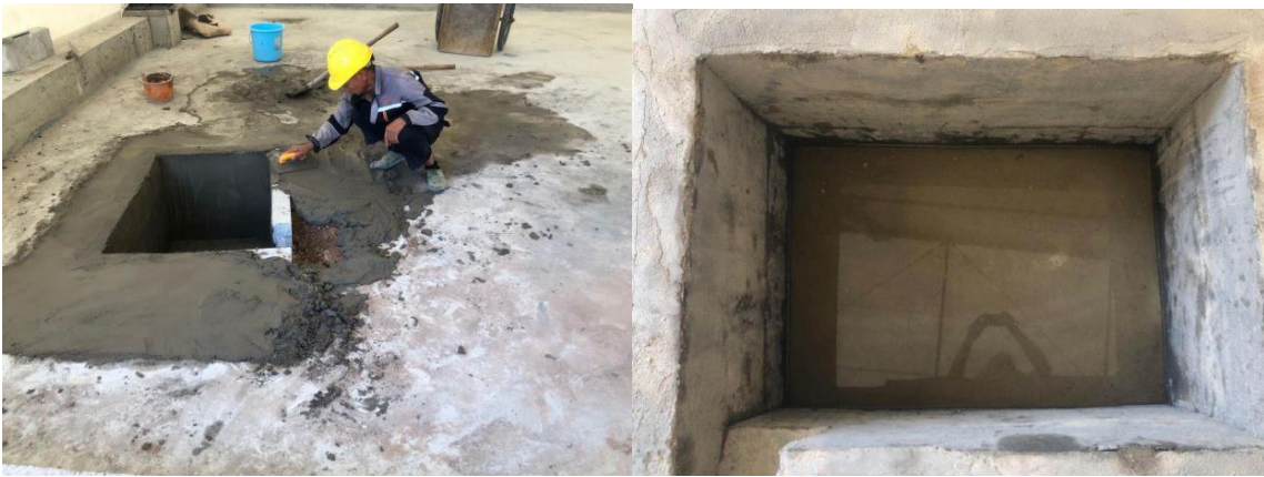
渣块冲洗区集水井建设
