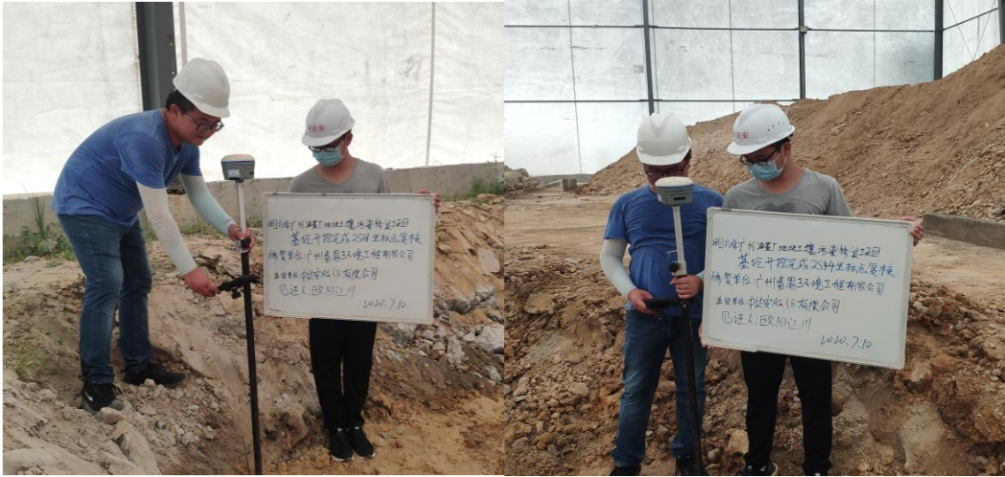
图2. 3-14放线定位、土方开挖及开挖后点位复核
