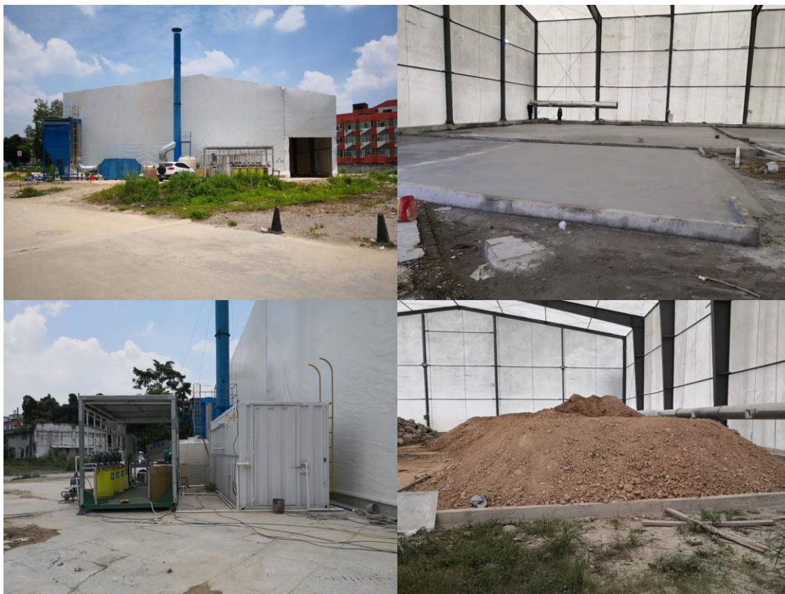
图3.2-1修复现场踏勘照片
