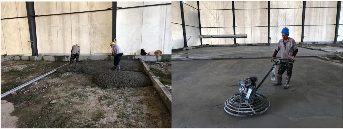
抗渗混凝土浇筑
