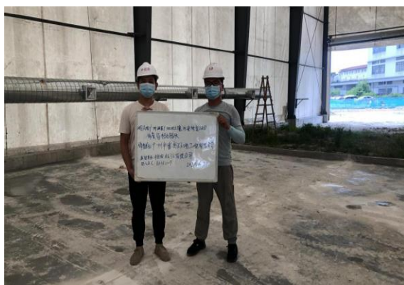
修复待检区建成监理验收
