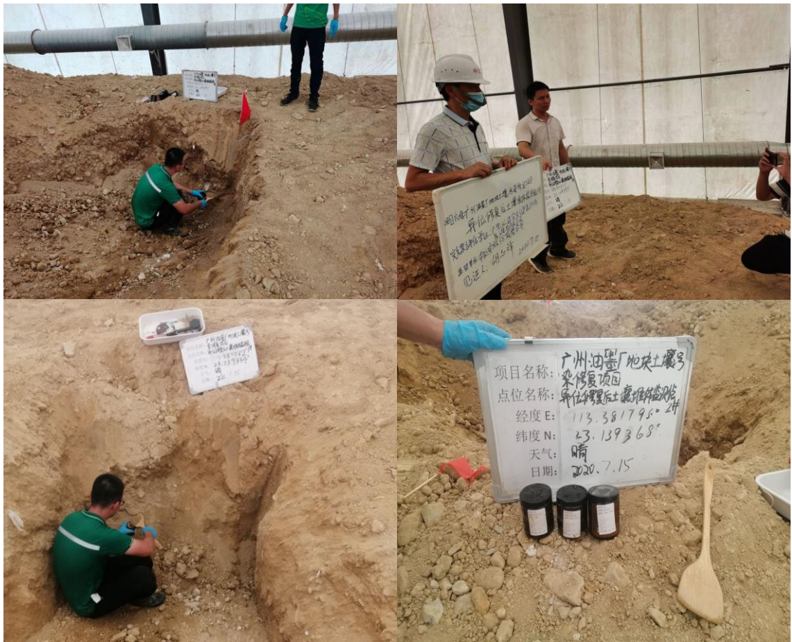
图5.2-4修复后土壤现场采样照片
