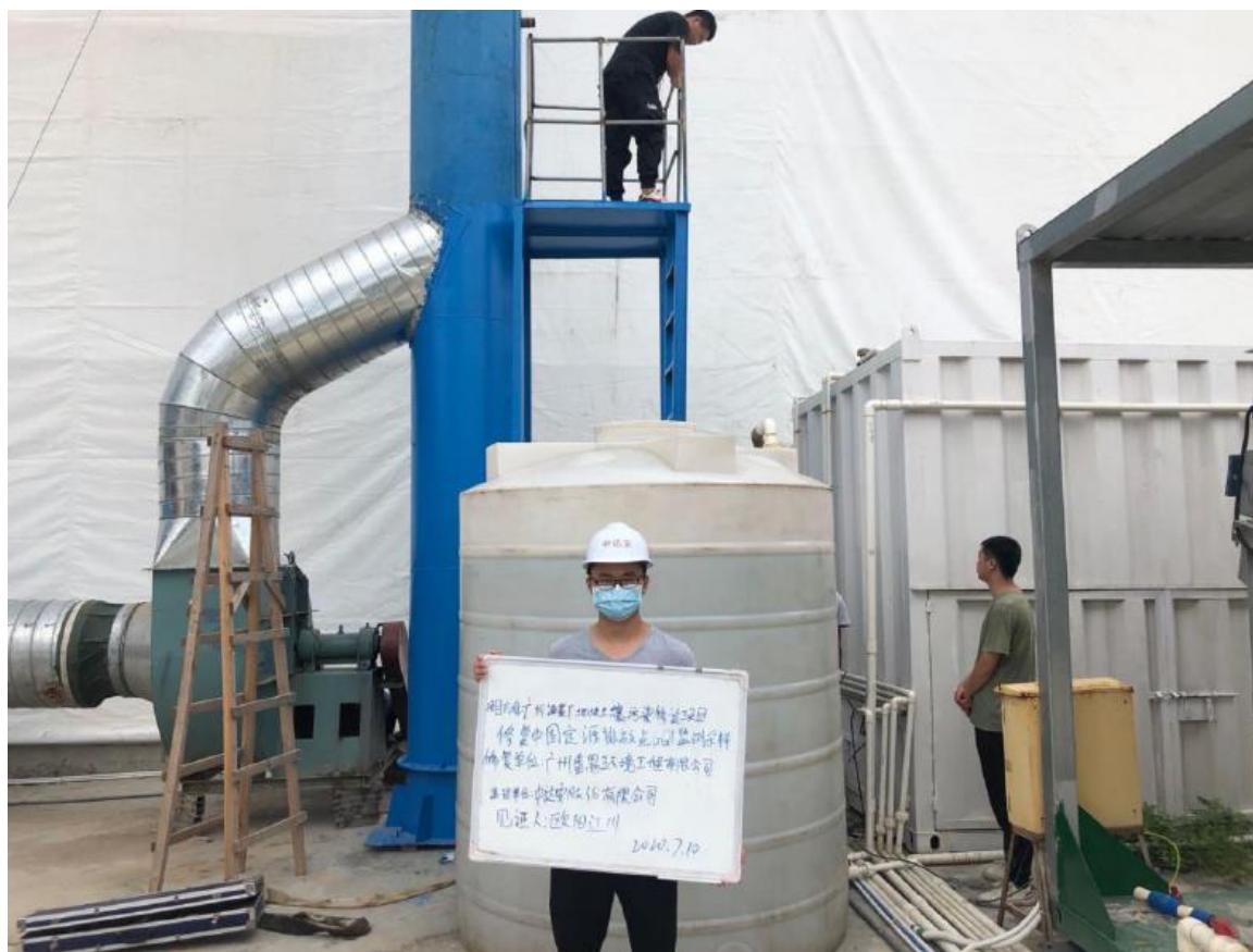
图2.4-8固定源排放监测点位监理旁站
