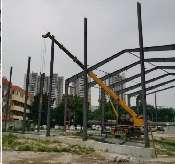
微负压大棚建设
