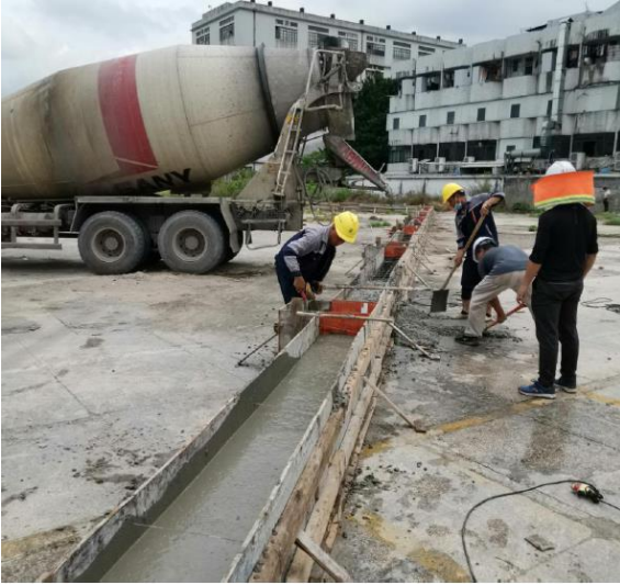
微负压大棚地梁浇筑
