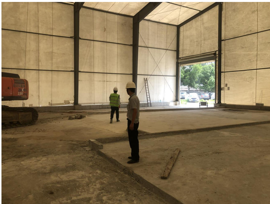
图2.4-1大棚内修复待检场实景图
