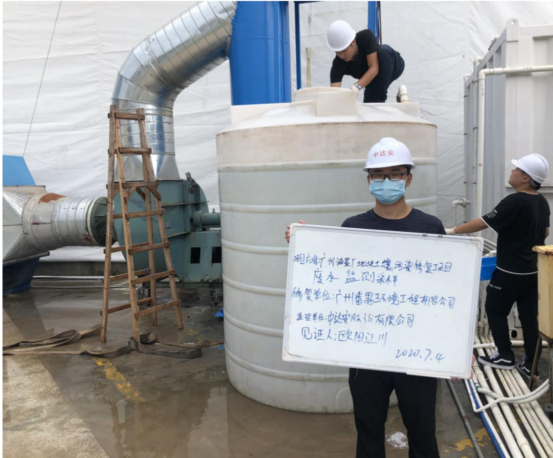
图2.4-2 污水处理后监测采样监理旁站
