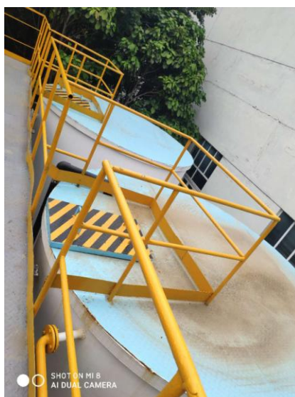
图 3-7 水处理站厌氧段及水解酸化段
