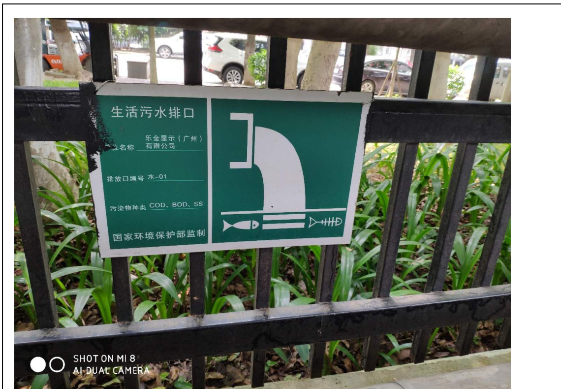
生活污水排放口标识
